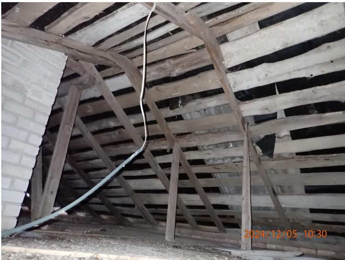
Nuotrauka Nr. 11. Medinių stogo konstrukcijų bendras vaizdas
