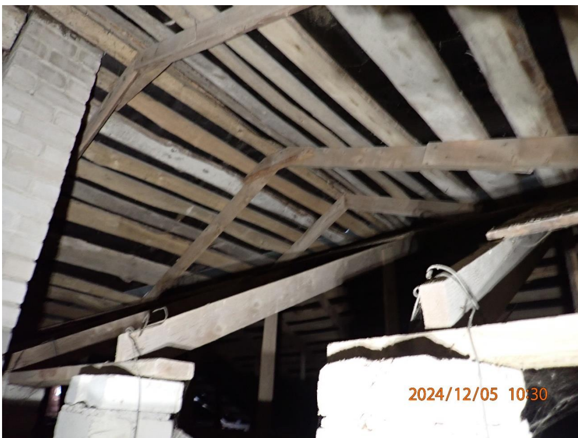
Nuotrauka Nr. 12. Medinių stogo konstrukcijų bendras vaizdas
